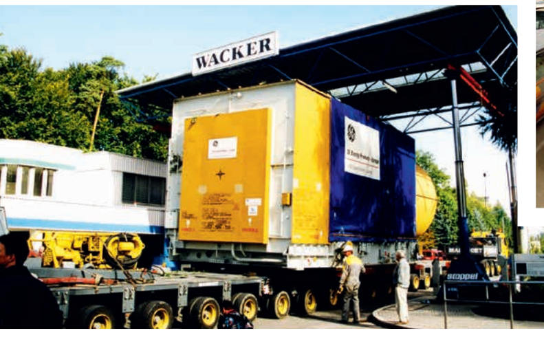
Das Dach der Hauptpforte Süd in Burghausen musste 2000 für Teile des neuen Gas- und Dampfkraftwerks angehoben werden
