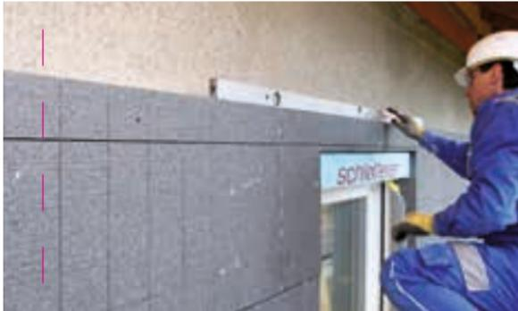
Wärmedämmverbundsysteme können bei entsprechender Vergütung des Klebemörtels mit Polymeren auf nahezu jedem Untergrund angebracht werden wie zum Beispiel:
