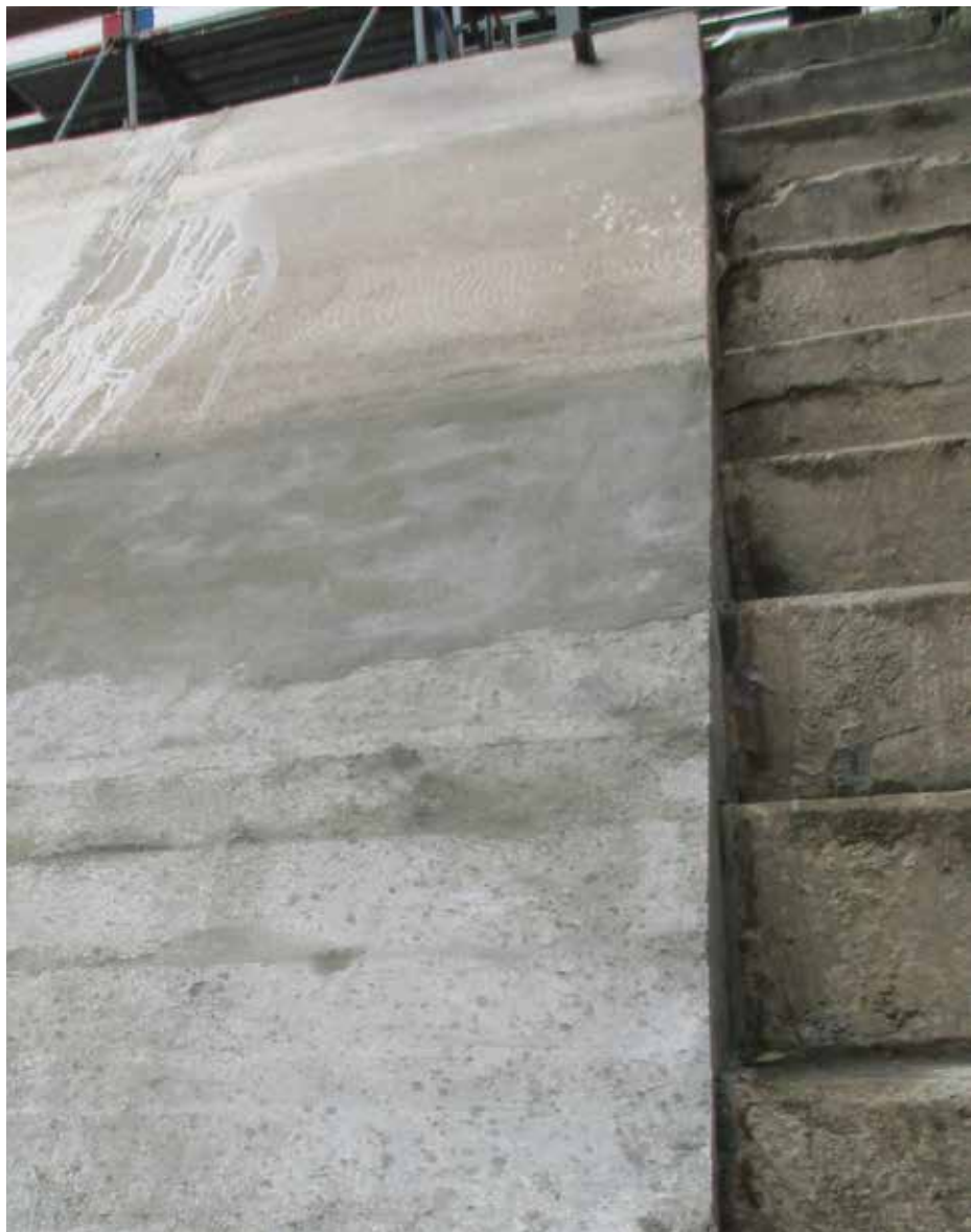
之后：光滑、无裂纹的混凝土表面。使用含ETONIS®的自充填混凝土进行修缮。
