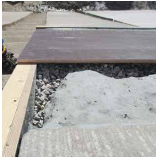
正在浇注自充填混凝土。
