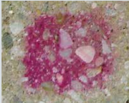
未改性混凝土： 未变色区域表示已被碳化的混凝土。
