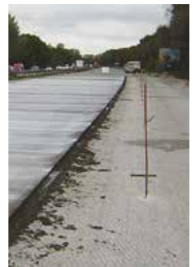
施工人员并没有将整个路面完全翻新，而只是将受损层碾碎，然后重新铺设一层面层，将原有的道路材料用作地基。
