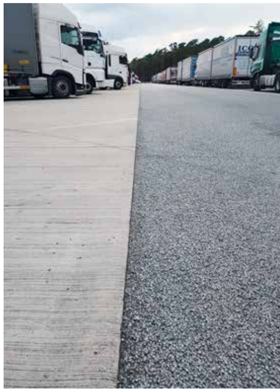
经过两年的气候影响和卡车的频繁碾压，混凝土层仍然完好如初。
