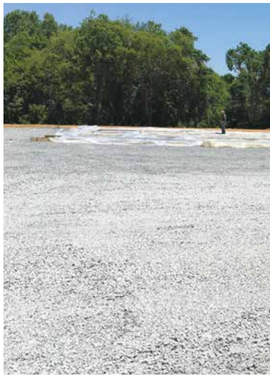
研究人员正在铺设改性透水混凝土
