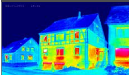
Figura 2: Imagens térmicas das fachadas As casas à esquerda e à direita foram isoladas e a do meio não foi.
