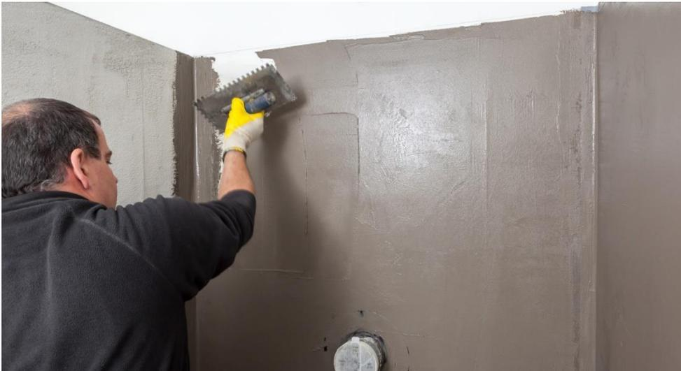
Auf der ECS 2023 stellt WACKER zwei neue polymere Dispersionen zur Formulierung von Dichtungsschlämmen vor: VINNAPAS® 754 ED und VINNAPAS® 764 ED. Sie verbessern die Verarbeitungseigenschaften des Dichtmörtels und tragen dazu bei, dass Risse auch noch bei Temperaturen unter dem Gefrierpunkt überbrückt werden. (Foto: WACKER)
