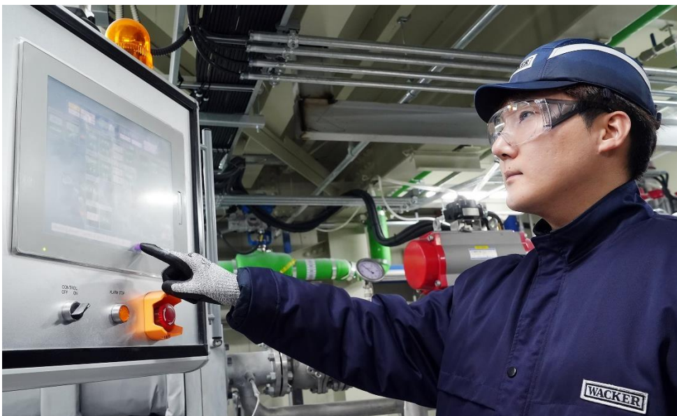
瓦克自 2010 年开始在韩国镇川为亚洲市场生产有机硅密封胶，现在，又一条生产线投入运行。（图片：瓦克）
