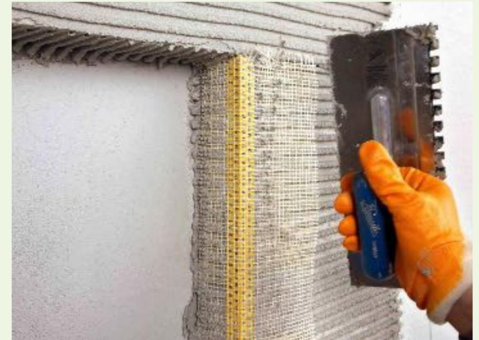
Ein Handwerker befestigt ein Wärmedämmverbundsystem an einer Fassade. Der Klebemörtel, auf dem die eigentliche Dämmung angebracht wird, benötigt Vinylacetat-Ethylen-Dispersionen, um die nötige Haftung zu entfalten.
