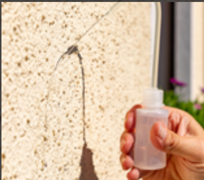
Der Karsten-Röhrchen-Test zeigt: Wasser perlt einfach an der Fassade ab – der Anstrich hält auch nach 20 Jahren noch dicht.
